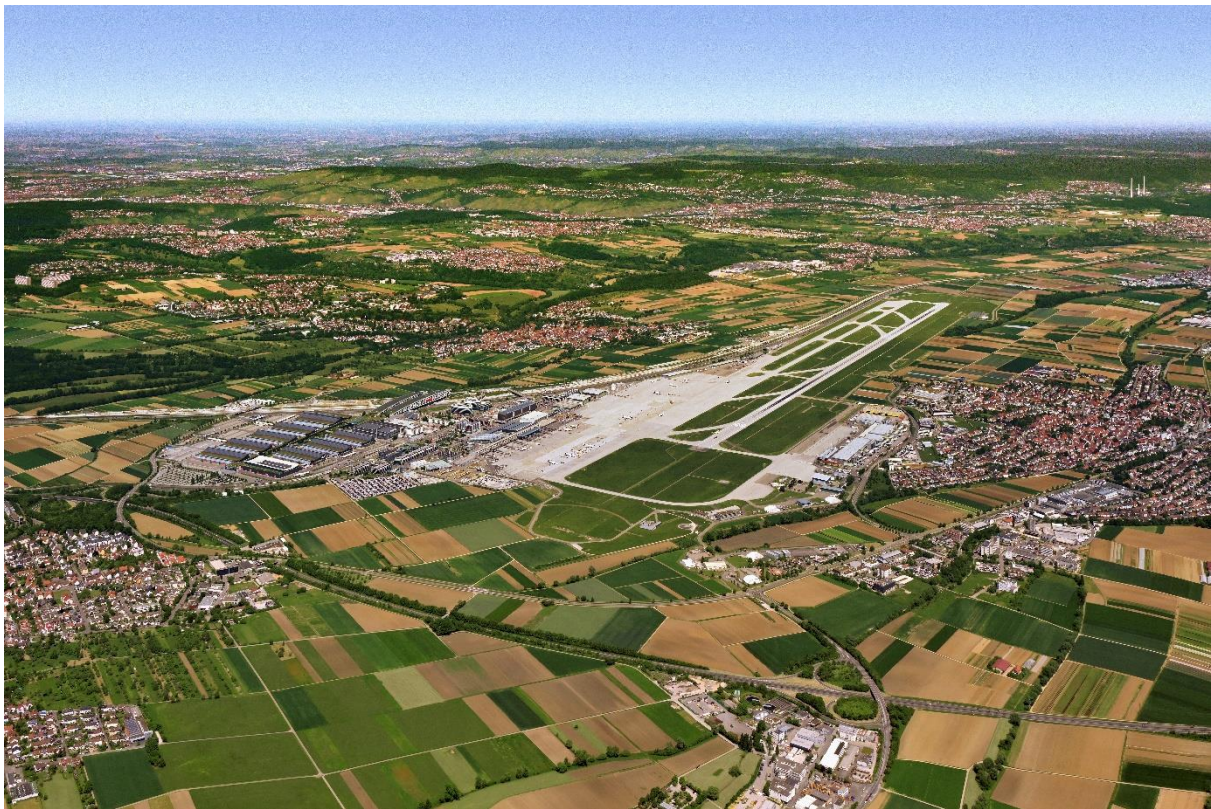
Abbildung 2: Luftbild Flughafen Stuttgart 2023 (Quelle: Flughafen Stuttgart GmbH)
